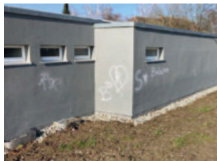
Das neue Feuerwehrhaus in Markelfingen wurde an der Ostfassade beschmiert. Bild: Ortsverwaltung
